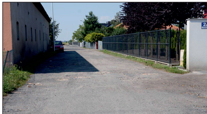
Przebudowa ulicy Pszennej w Wilkowicach.
