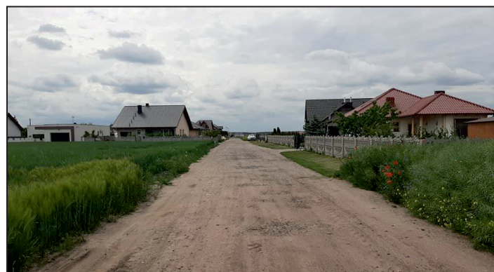
Przebudowa ulicy Granicznej w Lipnie.
